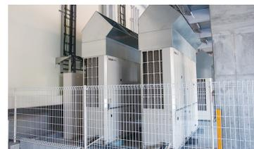
▲低温冷凍庫の熱源機 MSAV形コンデンシングユニット
