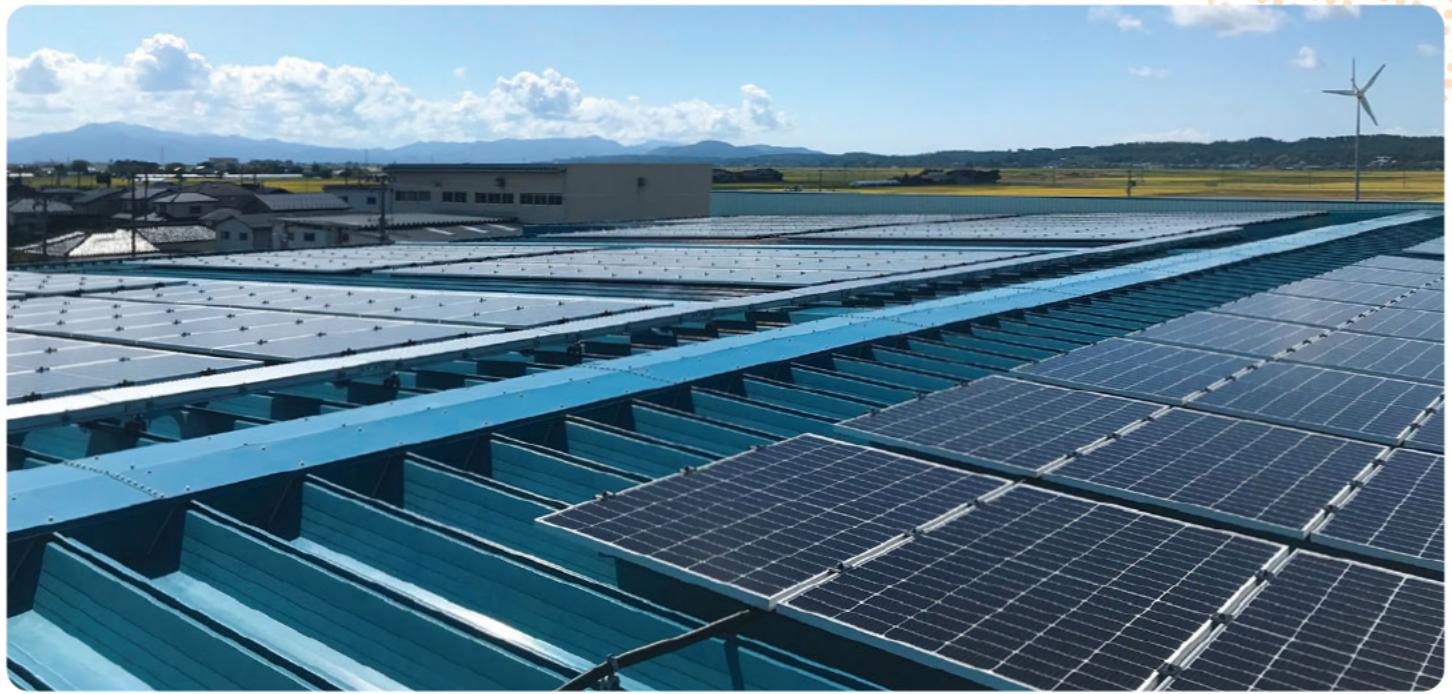
重量分散とメンテナンス通路確保のため、太陽電池モジュールは屋根上の広範囲に散らして配置。積雪時のメンテナンスも考慮した
