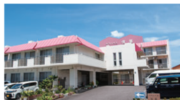
▲施設はSC造3階建、延床面積約1,784㎡、定員35名
