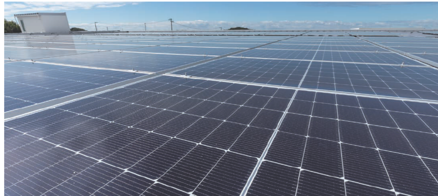
2024年3月竣工の新棟と既設棟の屋根面積を有効活用し、電力需要のシミュレーション結果に応じた適正枚数の太陽電池モジュールを設置しています。
